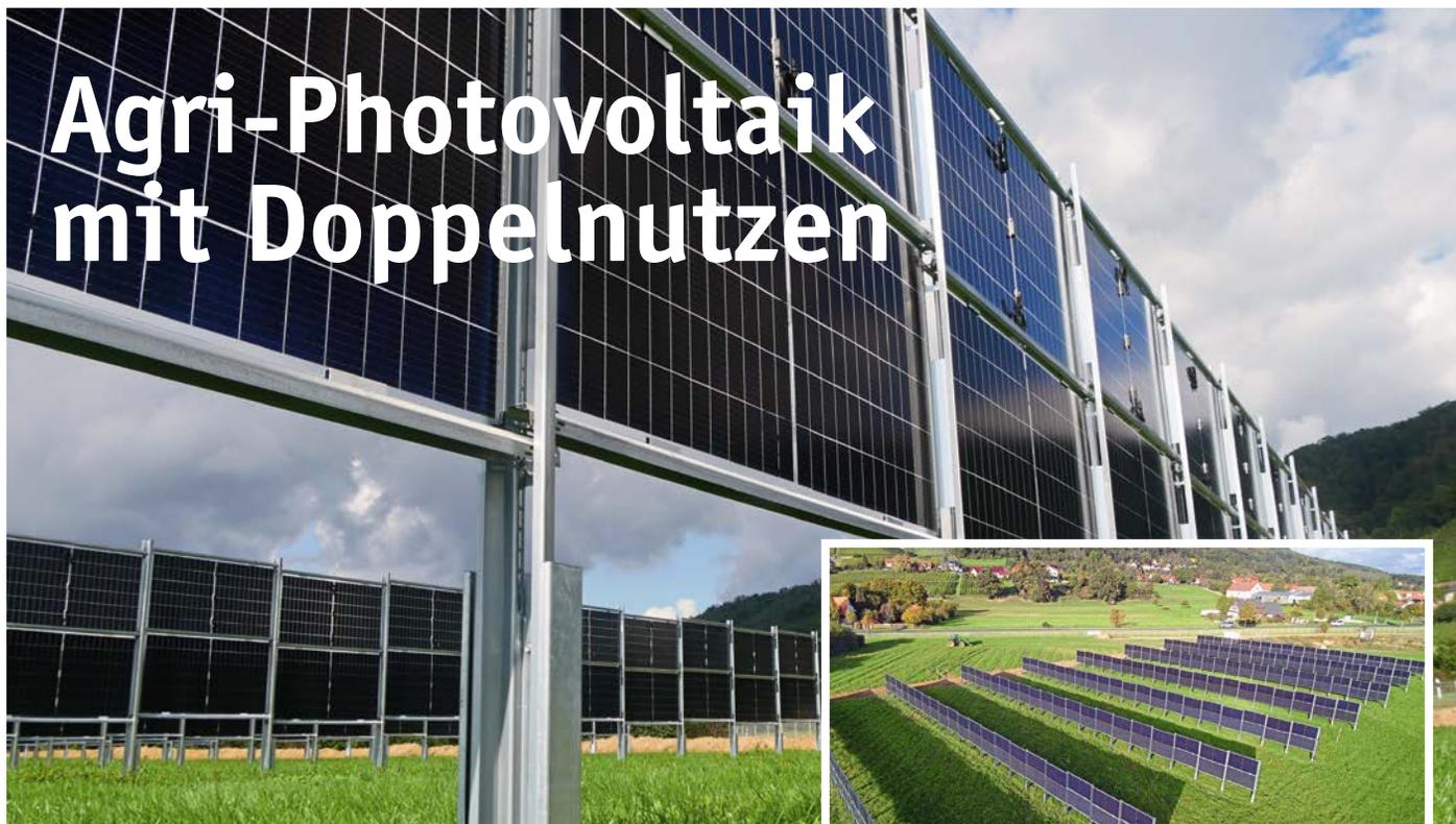
Die Anlage hat eine Leistung von 140 kW und besteht aus beidseitigen (sogenannten bifazialen) und senkrecht aufgestellten Modulen, die in Reihen von Nord nach Süd verlaufen. Die Module erzeugen sowohl über die Vorder- als auch über die Rückseite Strom, der für etwa 40 Haushalte ausreicht.
