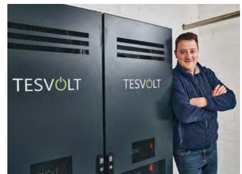
Landwirt Felix Borchers speichert seinen Solarstrom mit einem Tesvolt Batteriespeicher. Bildquelle: Tesvolt
