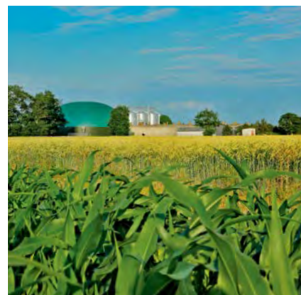
Blick auf die Biogas- und PV-Anlage der LVV-Ökozentrum Werratal/Thüringen Betriebs GmbH in Vachdorf südlich von Suhl.
