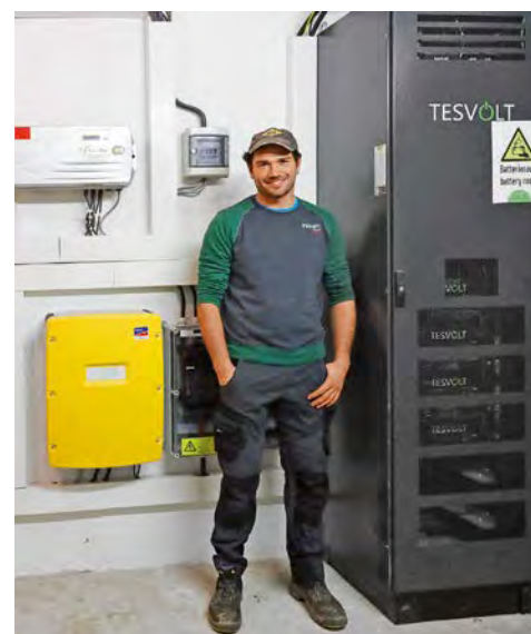
Landwirt Andreas Hartmann speichert seinen Solarstrom in einem Tesvolt Batteriespeichersystem.
